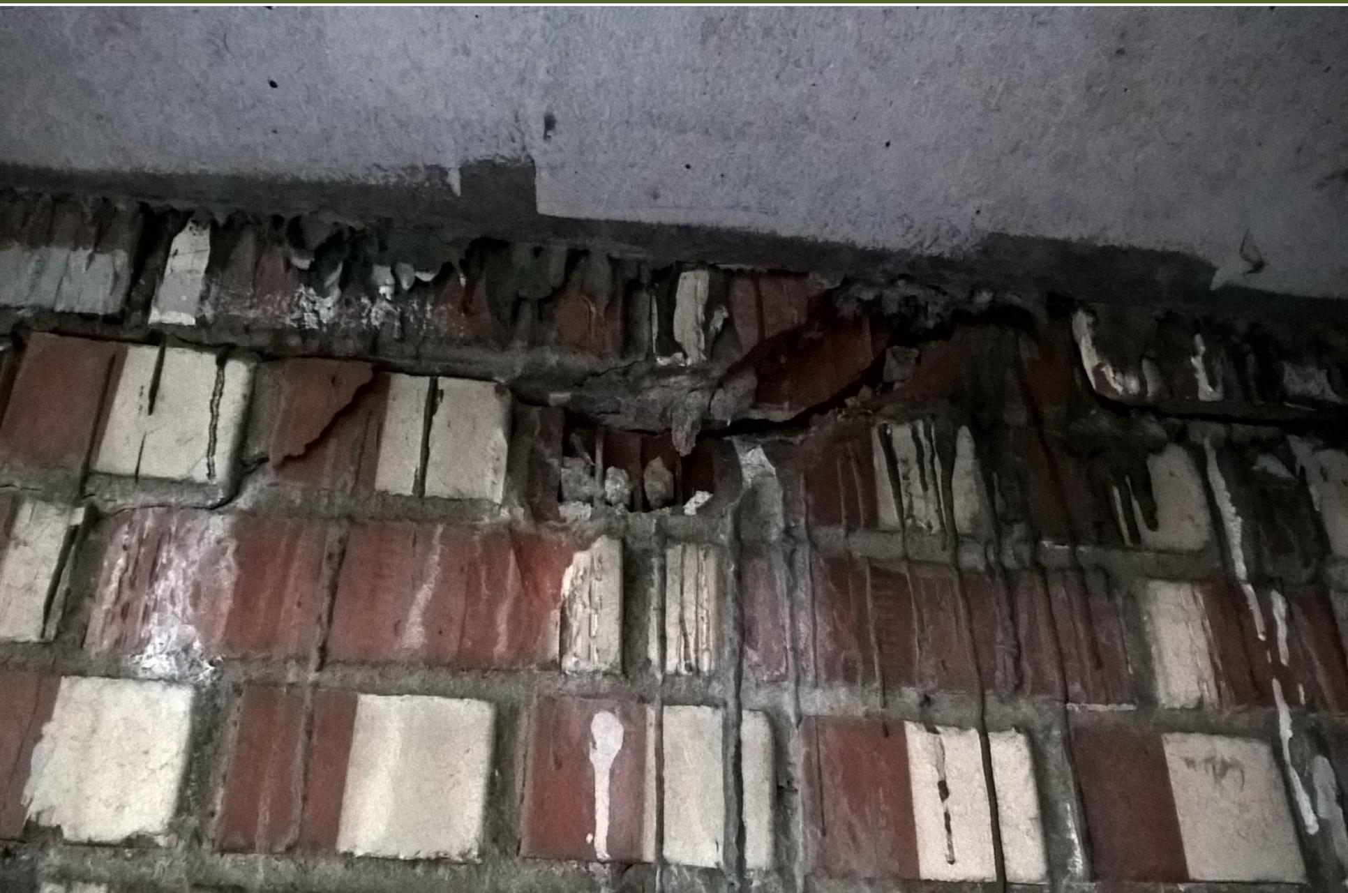
Протечка привела к разрушению межэтажных перекрытий
